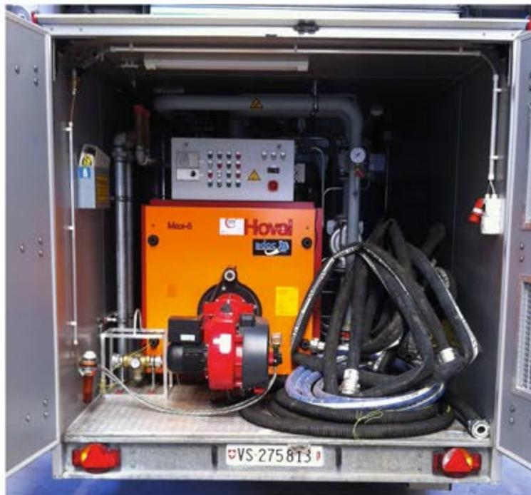
**Chaufferie mobile sur remorque puissance max 550 kW**
